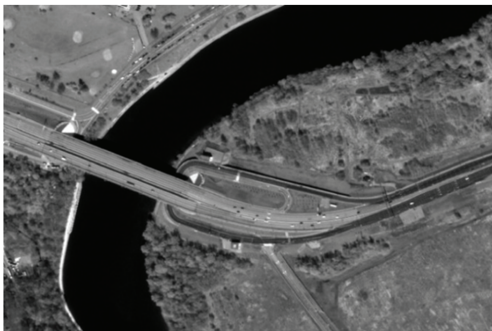
Рис. 2 / Fig. 2. Новый Крылатский мост и развязка с улицы Нижние Мнёвники. Космический снимок, 2021 г. / New Krylatsky bridge and interchange from Nizhniye Mnevniky street. Space snapshot, 2021
