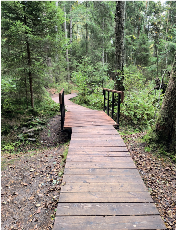
2а. Начало работ по расширению экотропы, обусловленных необходимостью предотвратить дальнейшую дигрессию растительного покрова вдоль настила
