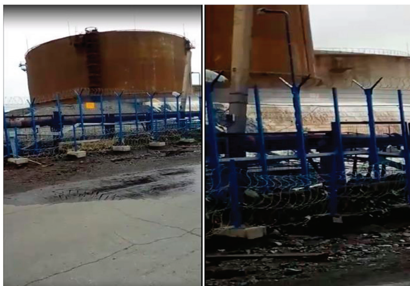
Рис. 3 / Fig. 3. Разлив нефтепродуктов на резервуаре РВС-20000 в г. Норильске. Начало разгерметизации. / Spill of oil products on the RVS-20000 tank in the city of Norilsk. Depressurization begins.
