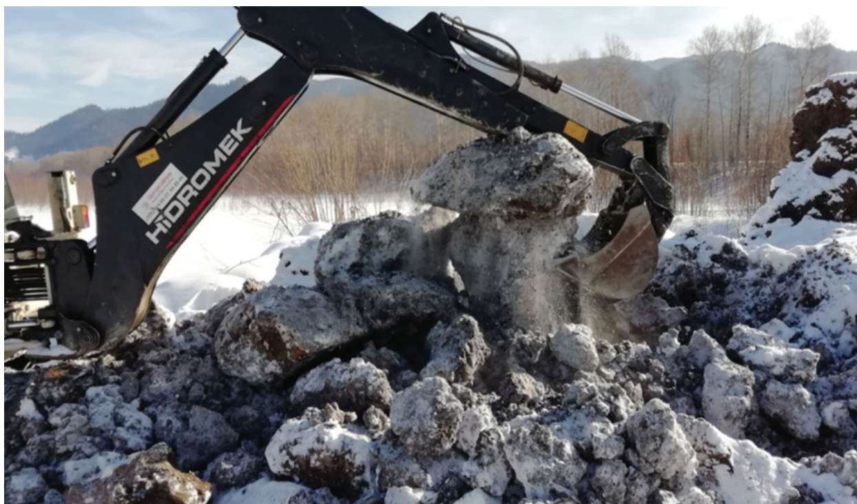
Рис. 3 / Fig. 3. Планировка площадки вымораживания осадка на Солзанской промплощадке ОАО «Байкальский ЦБК», февраль 2019 г. / Layout of the sludge freezing site at the Solzan industrial site of Baikal Pulp and Paper Mill, February 2019
