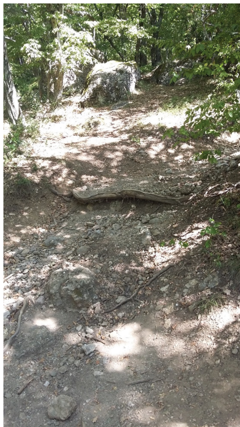
Рис. 6 / Fig. 6. Выбитое полотно тропы на участке пер. Куршум-Богаз – Аязма-Чокрак / Knocked out trail bed on the section of the Kurshum-Bogaz - Ayazma-Chokrak pass
