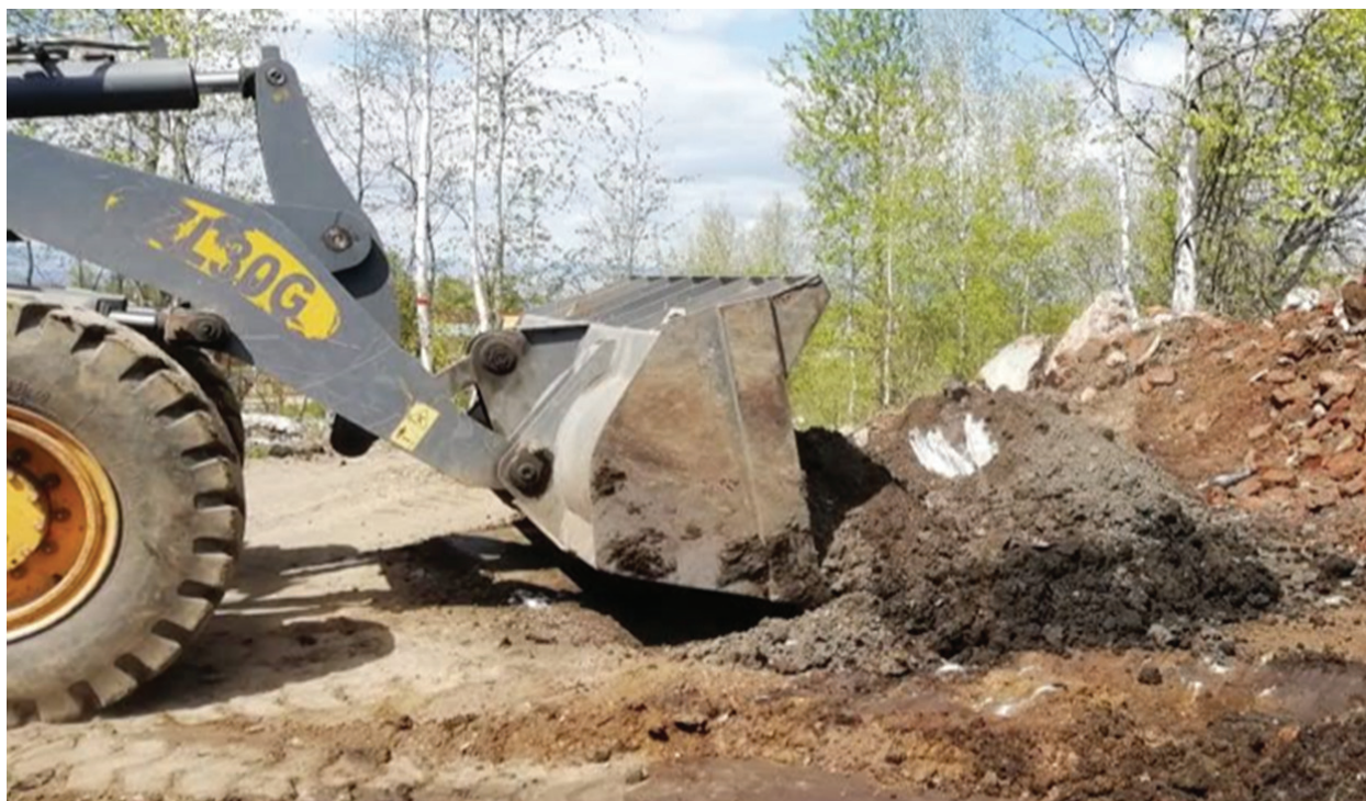
Рис. 4 / Fig. 4. Формирование опытных делян почвогрунта, полученного из вымороженных лигнинсодержащих осадков на Солзанской промплощадке ОАО «Байкальский ЦБК», май 2019 г. / Formation of experimental plots of soil obtained from frozen lignin-containing sediments at the Solzan industrial site of Baikal Pulp and Paper Mill, May 2019
