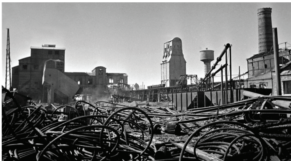
Рис. 3 / Fig. 3. Разрушенная шахта «Кочегарка» в городе Горловке. РИА Новости / Destroyed mine “Kochegarka” in the city of Gorlovka. RIA Novosti
