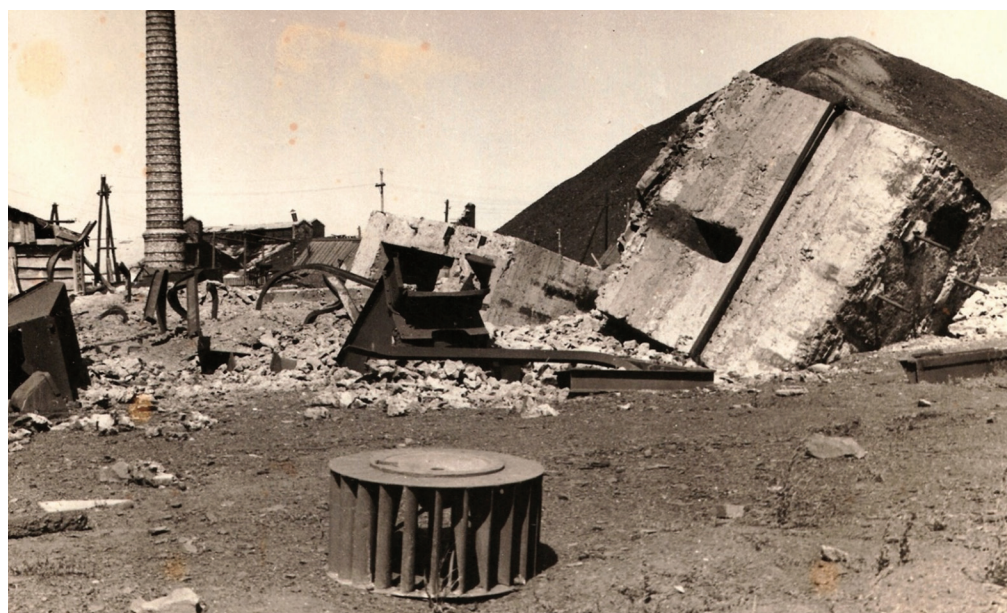
Рис. 1 / Fig. 1. Разрушенная шахта им. П. Войкова. Одна из старейших и продуктивных шахт Донбасса / Destroyed mine named after P. Voikov. One of the oldest and productive mines in Donbass
