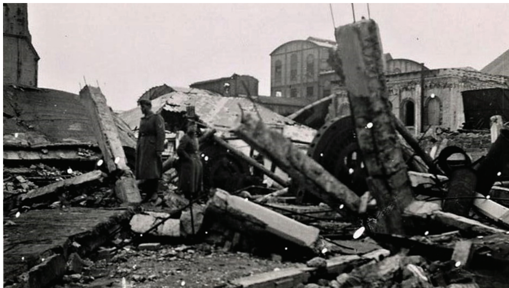
Рис. 2 / Fig. 2. Взорванная шахта. 1942 г. Надпись на обороте: “Gorlowka 1942 von den Russen gesprengtes Bergwerk” / Blown up mine. 1942 Inscription on the back: “Gorlowka 1942 von den Russen gesprengtes Bergwerk”
