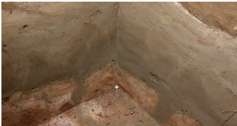
Рис. 5 / Fig. 5. Проявления мерзлотных процессов в нижней части разреза / Features of the permafrost processes in the lower part of the section.
